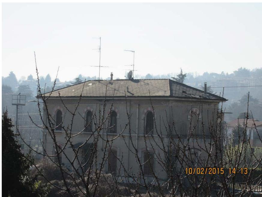
La bonifica dovrà essere eseguita con la stessa modalità prevista per il fabbricato precedente e la nuova copertura, anch'essa in lastre autoportanti coibentate da 30 mm di spessore, sarà fissata sull'orditura esistente eventualmente integrata, previa verifica in corso d'opera, da nuovi listelli in abete da mm 50x40.
