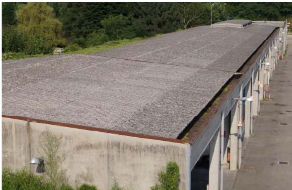
L'intervento consiste nell'approntamento del ponteggio sui prospetti laterali, così da non intralciare la normale attività di circolazione interna, per consentire l'accesso alla copertura. Si dovrà quindi provvedere al trattamento delle lastre ondulate con idoneo prodotto isolante e procedere allo smontaggio mediante rimozione delle viti di fissaggio ai listelli.
