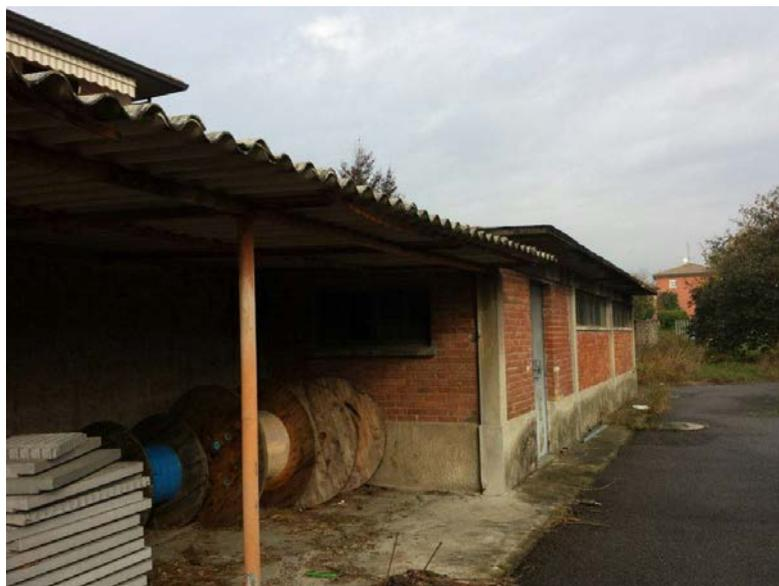
L'intervento è analogo ai precedenti con la differenza che i nuovi pannelli saranno sempre in lamiera 6/10 autoportante coibentata spessore mm 30 ma, supporto interno in lamiera anziché in velo vetro. Inoltre i pannelli dovranno essere fissati alla struttura metallica esistente senza l'interposizione dei listelli in legno. A completamento dei lavori, dovranno essere installati il canale di gronda con relativi pluviali in lamiera preverniciata con spaglio acque meteoriche sul suolo.
